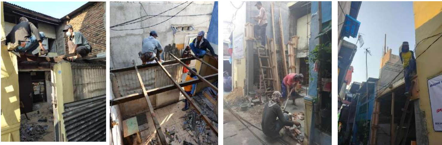
Tahap pembongkaran segmen yang akan dijadikan ruang pelayanan mustahik dan perpustakaan santri serta penambahan kamar
