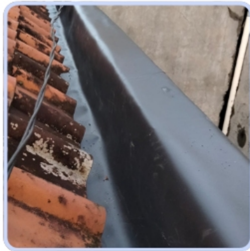
Perbaikan Atap Toilet Asrama
